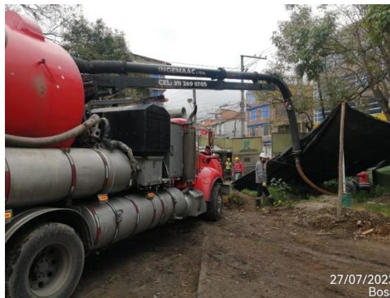
Mantenimiento a pozo séptico. Fecha: 27-07-2023.
